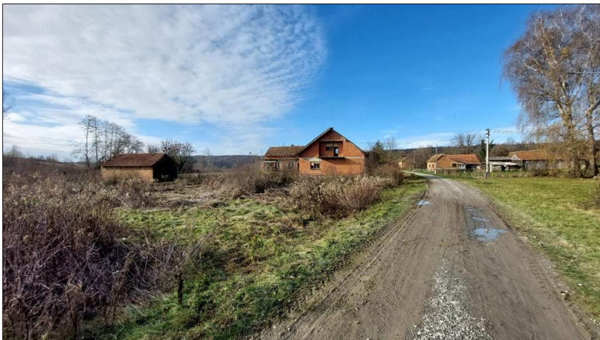
Slika 62. Fotografija - stanje cestovne infrastrukture i napušteni objekti stambene i poljoprivredne namjene izgrađenog dijela građevinskog područja u naselju Bedenička
