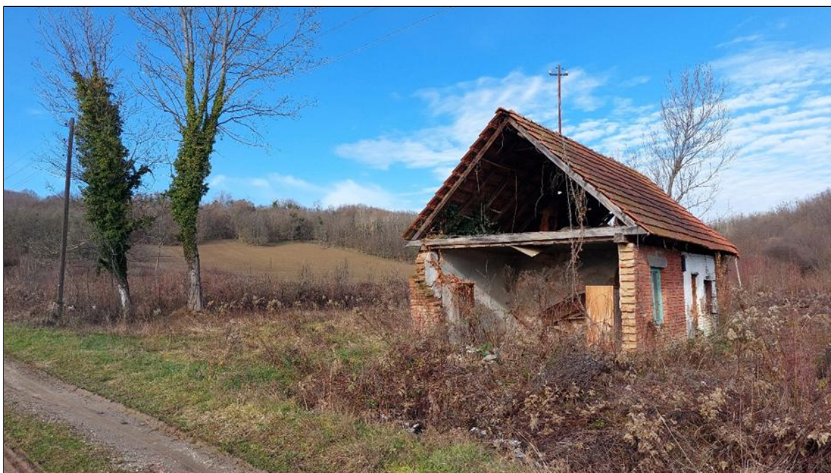
Slika 60. Fotografija - napušteni objekt stambene namjene izgrađenog dijela građevinskog područja u naselju Bedenička
