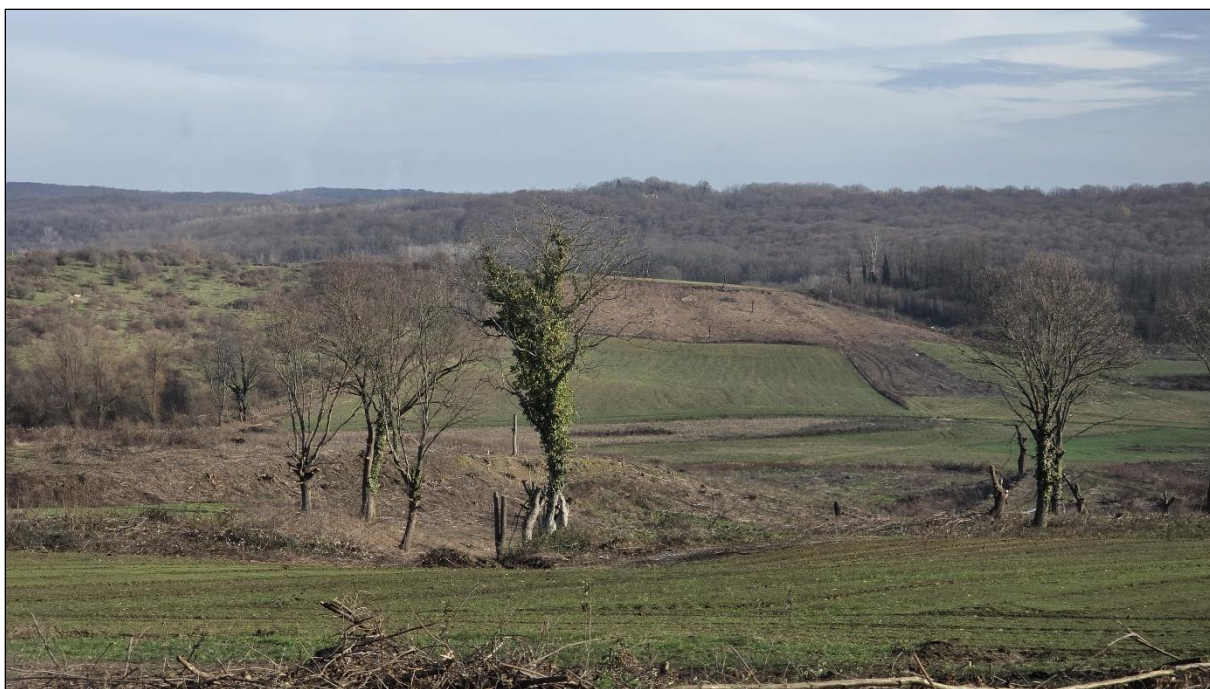
Slika 9. Uklanjanje vegetacije u naselju Zrinska (Foto: Zavod BBŽ)
